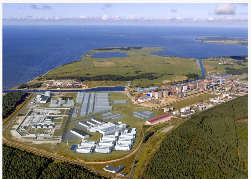
Luftaufnahme mit Visualisierung vom Wasserstoff-Hub in Lubmin mit geplanter PtX-Development-Großelektrolyseur-Anlage. © PtX Development
