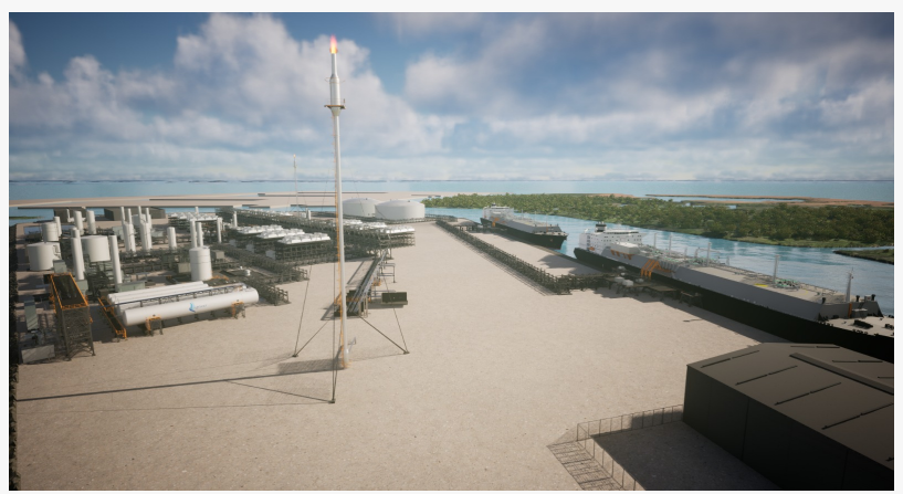
Argent LNG Tanks
