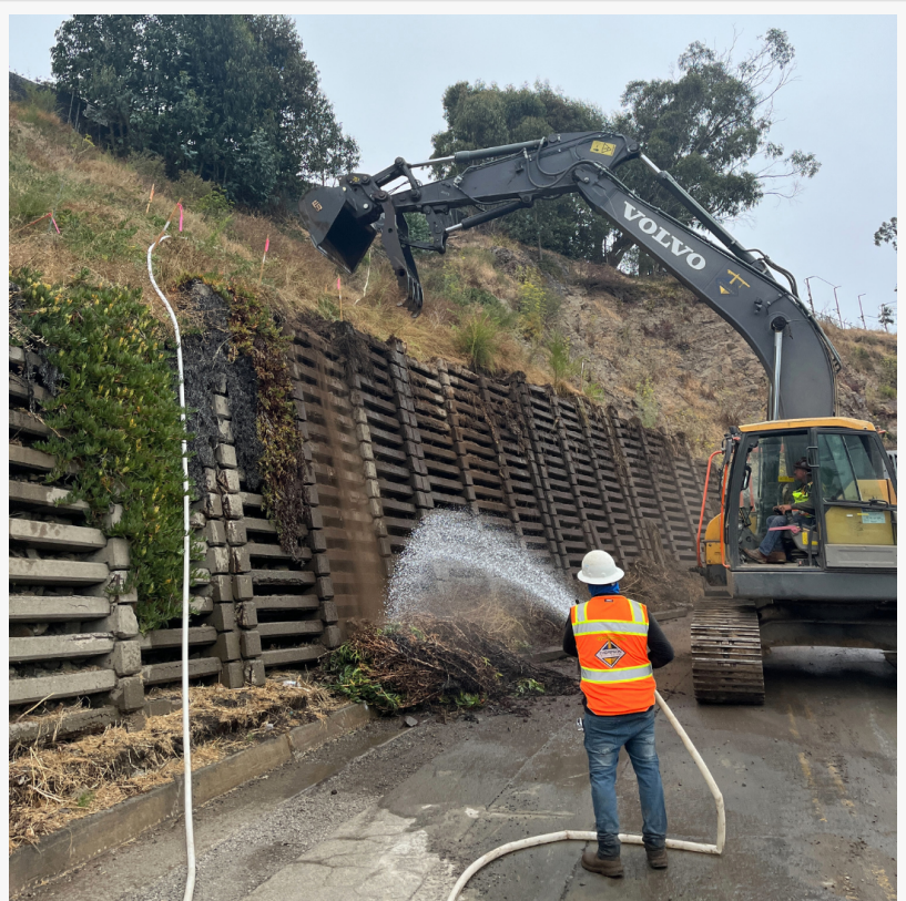
Yerba Buena Wall Demolition
